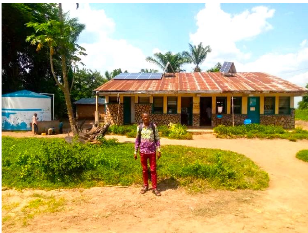
Bloc dispensaire ; sur le toit, les panneaux solaires de l'électrification du forage, à gauche, en bleu, citerne pour le stockage de l'eau
