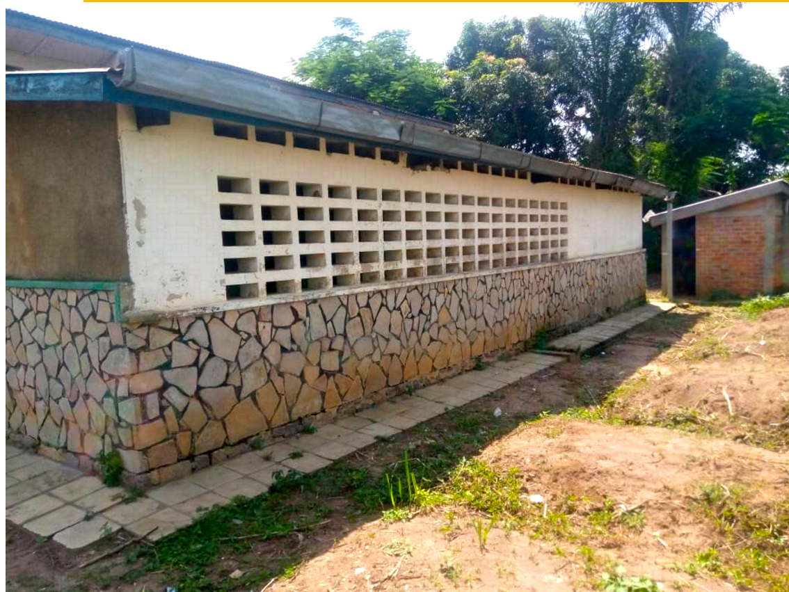
Façade arrière du bloc DISPENSAIRE, au fond à droite, INSTALLATION SANITAIRE
